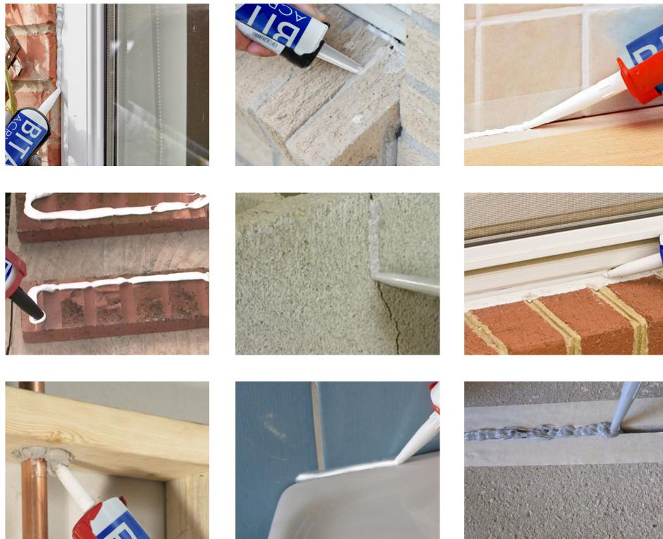
**Sealant yang mempunyai kelenturan luar biasa, cocok untuk mengisi dan mengikat celah atau sambungan lebar.**
