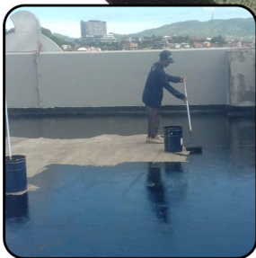
Apply Bitafix primer 0,2 kg/ m 2
